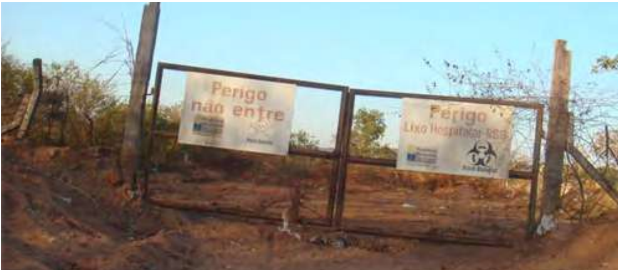
Figura 7 - Área de disposição final de RSS em Coxim/MS. Observa-se a sinalização, cercamento e o portão trancado. Fonte: Deméter Engenharia Ltda., 12/07/2011.
